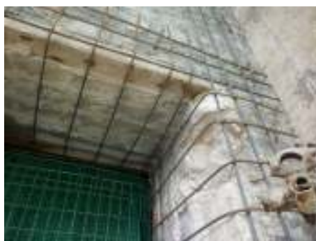
Σχήμα 9.22: Ενίσχυση τοιχοποιίας με οπλισμένο επίχρισμα.
