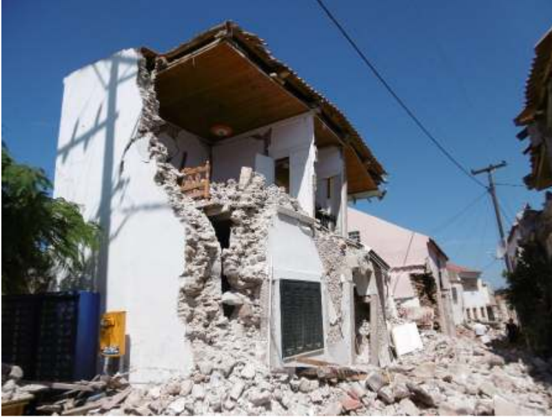
Σχήμα 8.2.: Αποκόλληση τοίχων και γωνιών.
